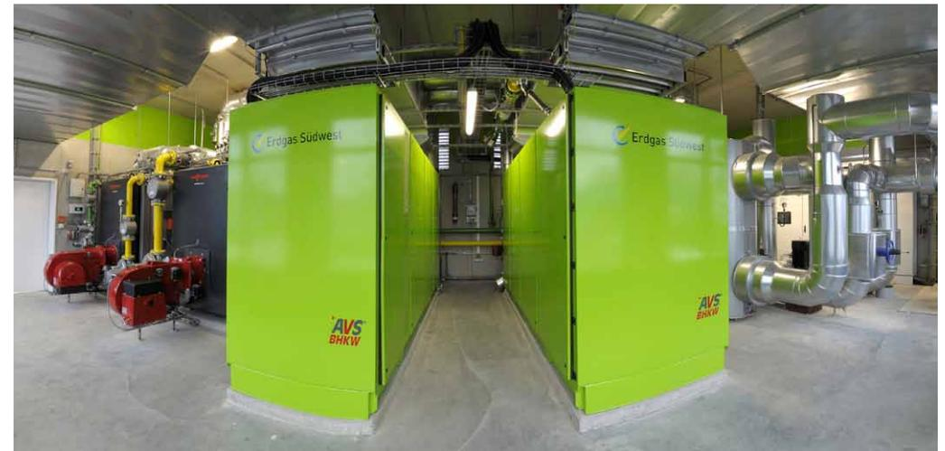
Kraftpakete auf regenerativer Basis: Die beiden Blockheizkraftwerke in der Uhlmann Pac-Systeme GmbH & Co. KG laufen mit regenerativem Biogas und werden von Erdgas Südwest in einem Contracting-Modell betrieben.
