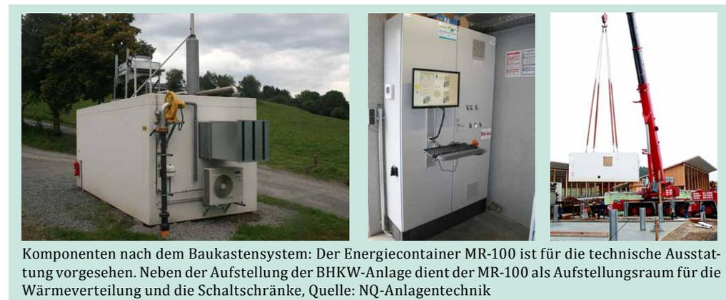
Komponenten nach dem Baukastensystem: Der Energiecontainer MR-100 ist für die technische Ausstattung vorgesehen. Neben der Aufstellung der BHKW-Anlage dient der MR-100 als Aufstellungsraum für die Wärmeverteilung und die Schaltschränke, Quelle: NQ-Anlagentechnik
