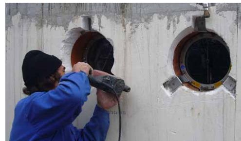
Einbau eines Köberle-Bullauges in einen Biogasgärbehälter und Blick auf die Gasblase im Gärbehälter
