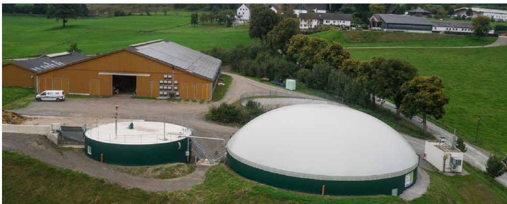
Eine 75 kW Biogasanlage aus dem Hause NQ-Anlagentechnik mit BHKW, Quelle: NQ-Anlagentechnik
