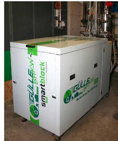
NQ-Gülle-BHKW 30 kW im eingebauten Zustand
